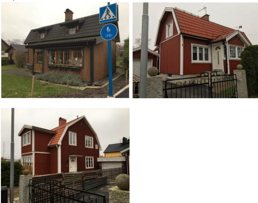
Bild 7 visar de befintliga husen inom fastigheterna Gamla stan 2:11 (övre rad, vänster), 2:13 (övre rad, höger) och 2:24 (nedre rad).
