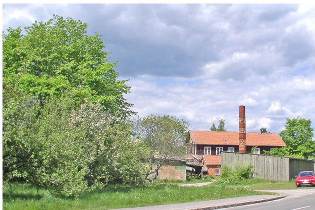
Den övergivna industrin sedd från Storgatan
