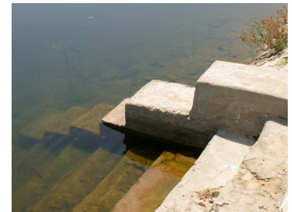
Trappor möter vattnet vid det upprustade ICA-torget
