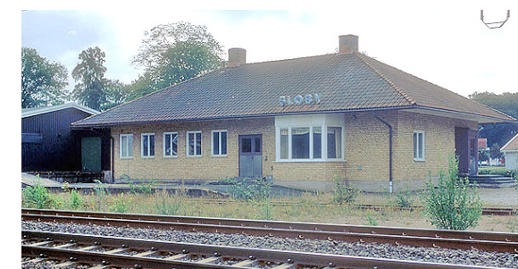
fd Floby stationshus, söder om järnvägen. Nyligen rivet.
