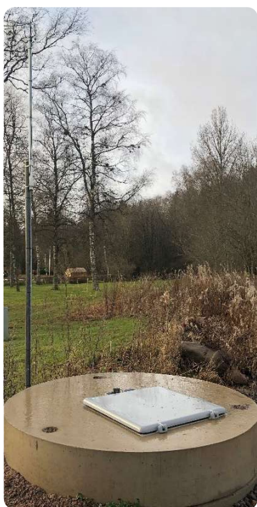
Vattenmätarbrunn med Lora antenn
