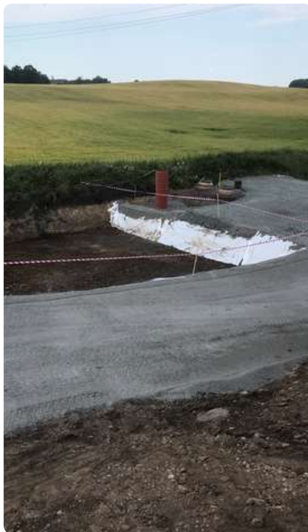
Schakt för pumpstation Saleby i Vartofta
