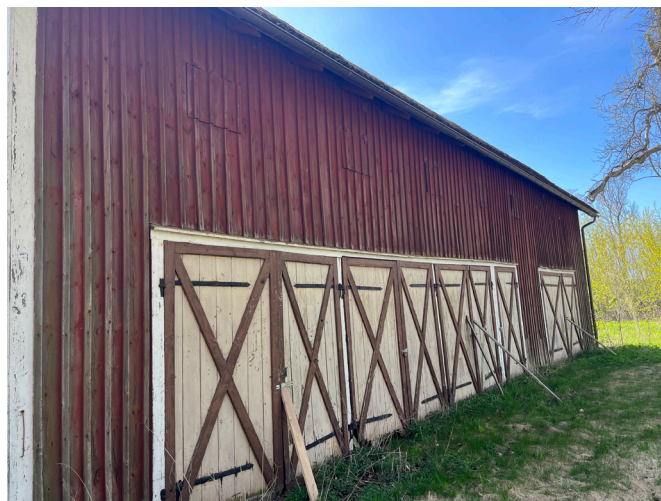
Ekonomibyggnad i sydost. Fasad mot väster med flera portar.
