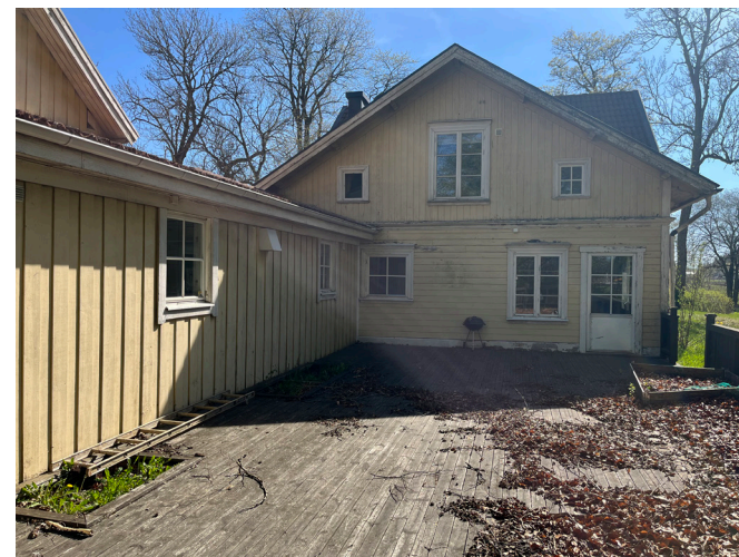
Boningshusets fasad mot väster som ansluter till förbindelsegång.
