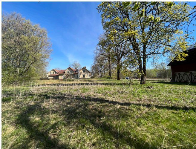
Tomtdel i söder med allé och huvudbyggnad.
