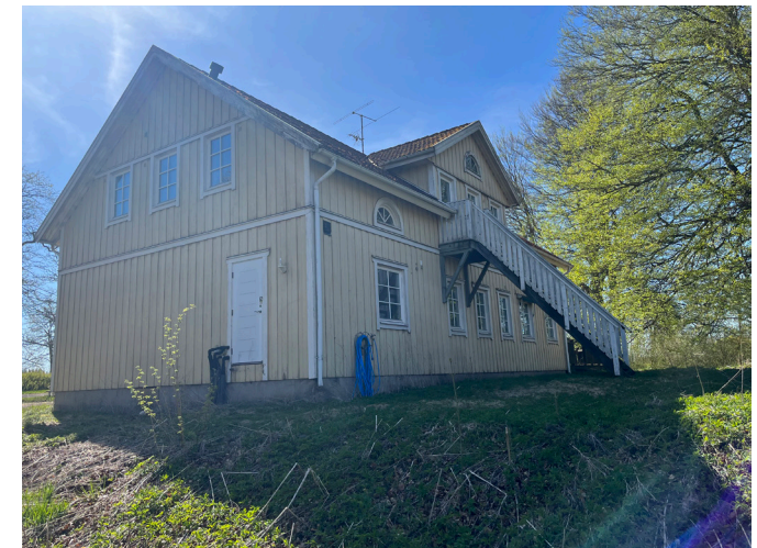
Gavel mot norr och fasad mot väster.
