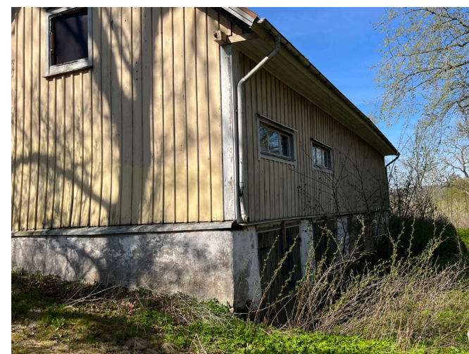
Del av gavel mot öster och fasad mot norr med större portar i källare.
