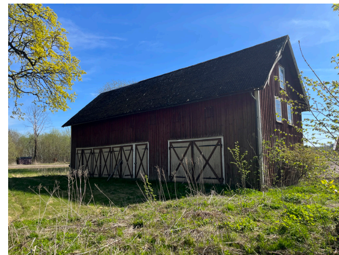
Ekonomibyggnad i sydost. Fasad mot väster samt gavel mot söder.
