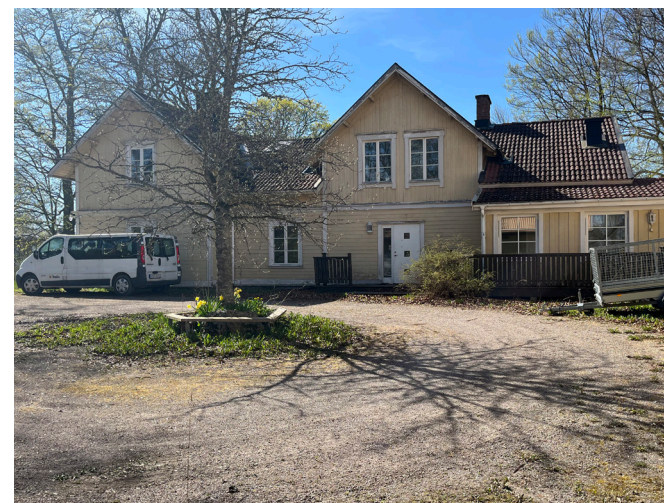
Boningshusets fasad mot norr och den kringbyggda gården.
