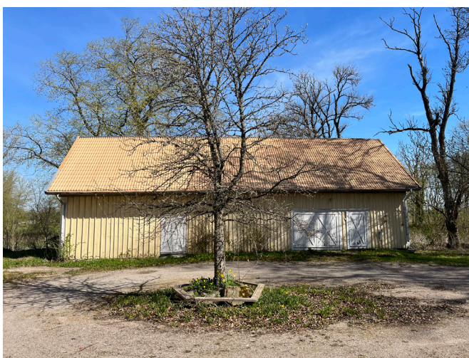
Ekonomibyggnad i norr. Fasad mot söder och den kringbyggda gården.
