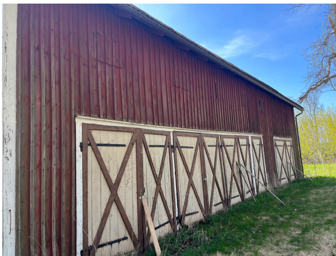
Ekonomibyggnad i sydost. Fasad mot väster med flera portar.
