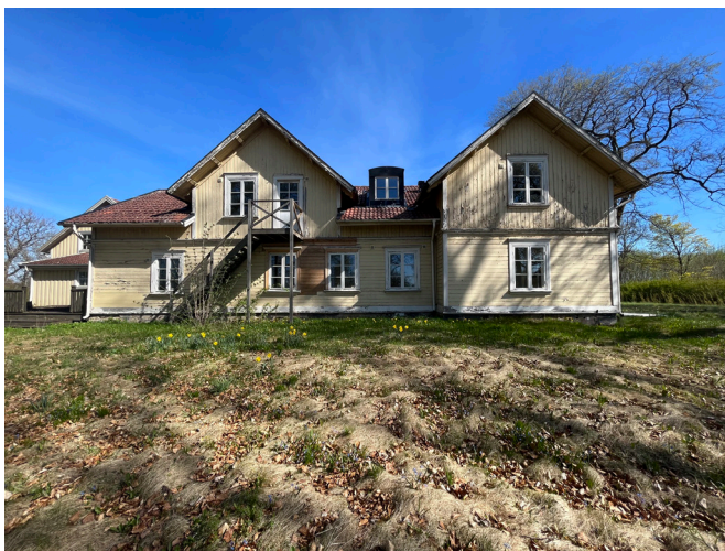
Boningshusets fasad mot söder.
