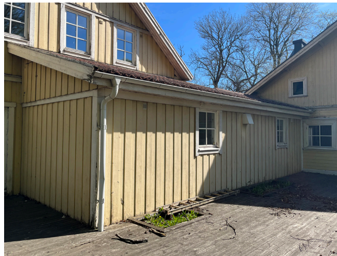
Förbindelsegång mot söder.
