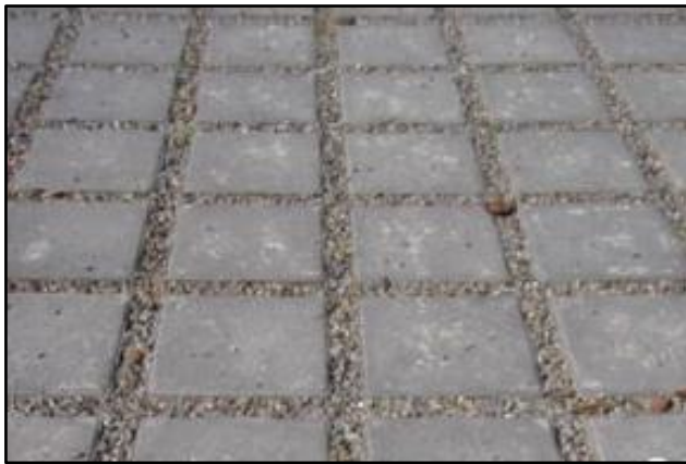
Figur 15. Exempel på genomsläpplig betongbeläggning med grusfogar.
